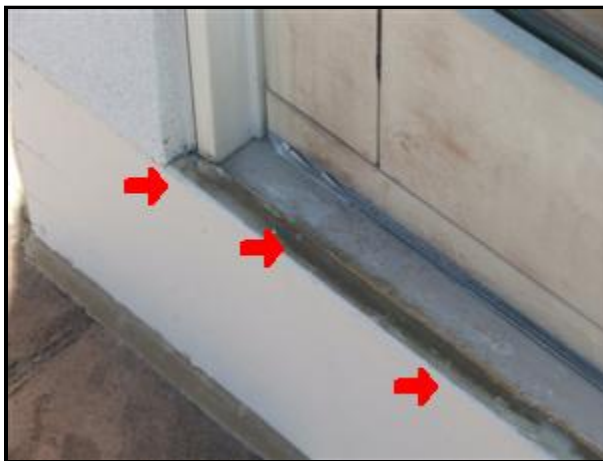
5.1 Picture 1 Door Jamb
